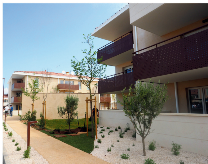
Résidence La Petite Provence 62 logements collectifs dont 30 en Locatif intermédiaire également appelé «Le Logement Idéal» à Saint Martin de Crau - 13
