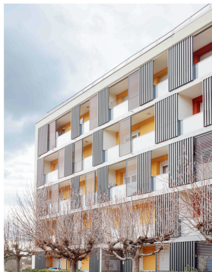
Livraison des travaux de réhabilitation La Marguerite à Apt - 140 logements
