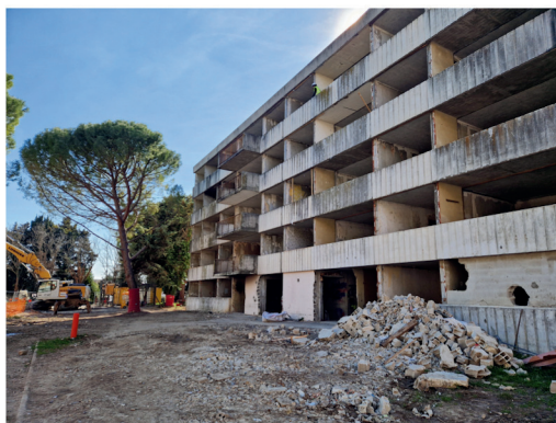
Travaux de démolition Résidence L'Aygues à Orange
