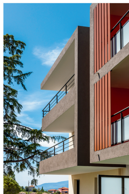
Résidence Edonis 21 logements collectifs à Nice - 06
